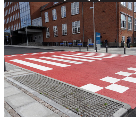
PlastiRoute® RollGrip® giver god skridsikkerhed i opbremsningszoner
