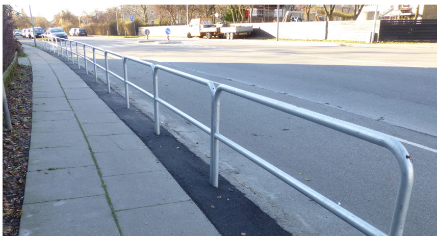
Sektionsrækværk type SR anvendt i forskudt fodgængerfelt med midtersluse
