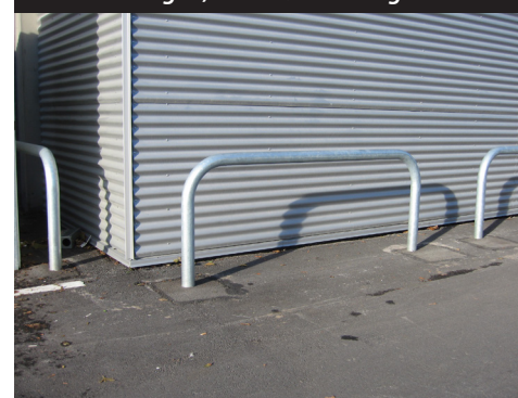
BÅX Buerør er her anvendt som beskyttelse mod påkørsel (Silvan)
